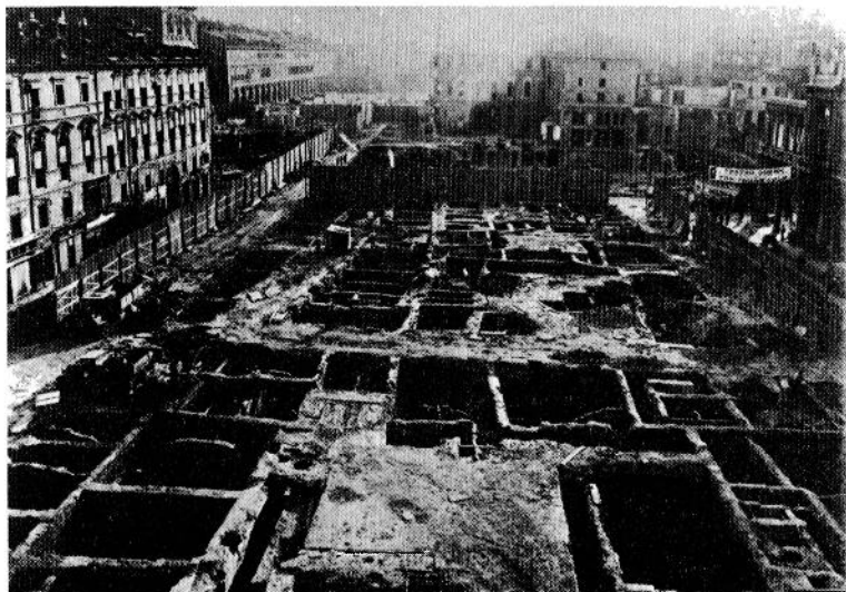
63. Edilizia e nuovi piani urbanistici: demolizioni nel centro storico di Torino per l'apertura di via Roma, Torino, 1931 (fotografia di M. Gambino; Torino, Galleria Civica d'Arte Moderna).
